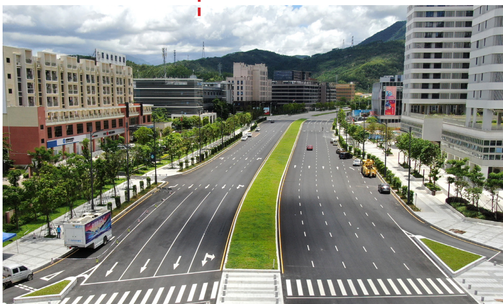
实景照片 提升前实景照片
